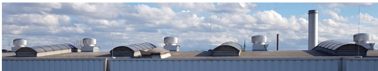
Abbildung (6) Firstaufbau Industriehalle - EcoPower 900
