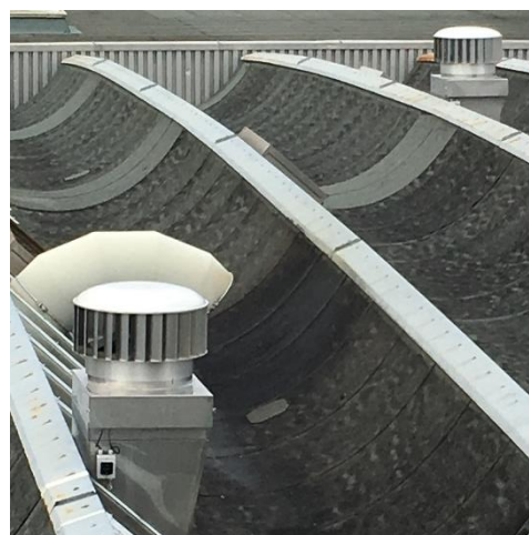
Abbildung (7) Hybridventilator EcoPower 600 mit Jalousieklappe in Fensteröffnung / Sheddach
