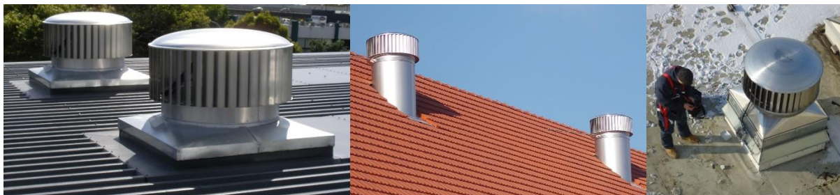
Abbildung (5) Hallenentlüftung Realisierungsbeispiele - Hybridventilator EcoPower 900
